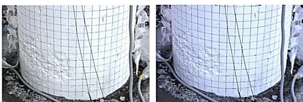
شکل ۷ - تصاویر دو دوربین نصب‌شده برای بررسی رشد ترک [۷]
