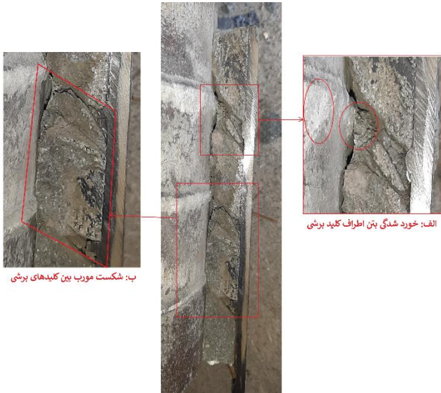
شکل ۱۱ - مود شکست بتن بدون الیاف (الف) خورد شدگی بتن اطراف کلید برشی (ب) ترک مورب برشی
