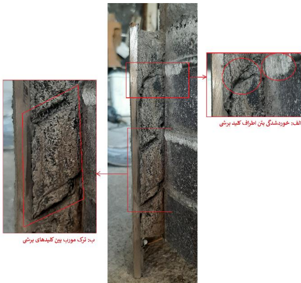
شکل ۱۲ - مود شکست بتن الیافی (الف) خورد شدگی بتن اطراف کلید برشی (ب) ترک مورب بین کلیدهای برشی
