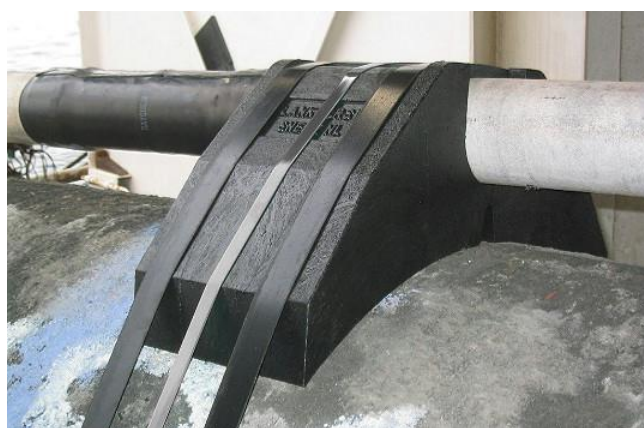
شکل ۲- قرار گرفتن لوله کوچک توسط تسمه و نشیمن‌گاه بر روی لوله اصلی (تصویر واقعی)
