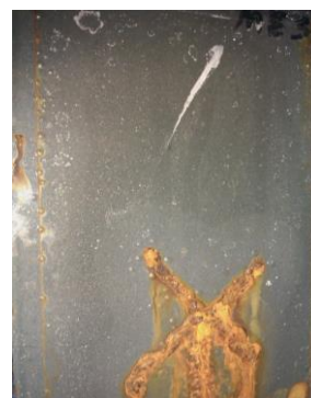
شکل ۱۱- وضعیت سطح پانل پس از اتمام آزمایش مه نمکی
