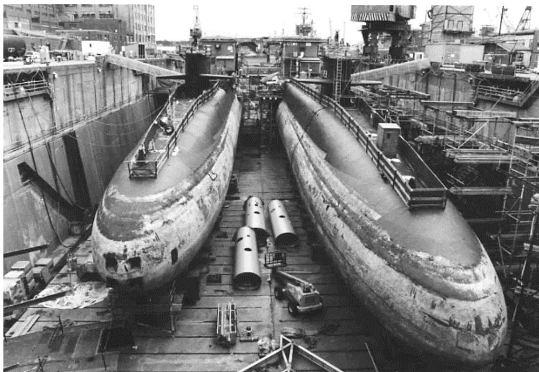
شکل ۱- قرار گیری زیردریایی‌های فرسوده در یک داک خشک برای جداسازی محفظه و بازیافت [۲]
