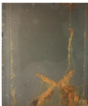
شکل ۱۳- وضعیت سطح پانل پس از اتمام آزمایش مه نمکی
