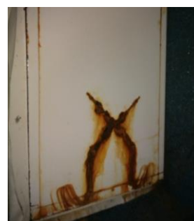
شکل ۱۵- وضعیت سطح پانل پس از اتمام آزمایش مه نمکی
