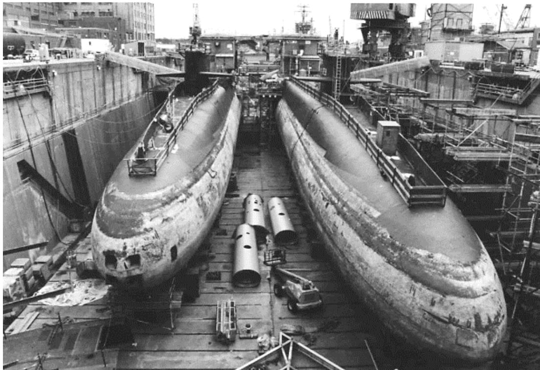
شکل ۱ - قرار گیری زیردریایی‌های فرسوده در یک داک خشک برای جداسازی محفظه و بازیافت [۲]
