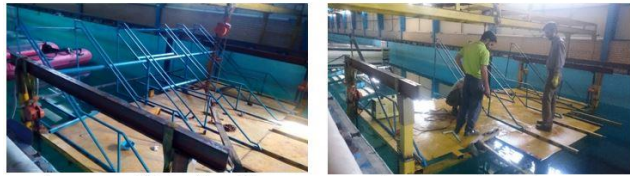
ج: رنگ‌آمیزی قاب‌های شابلونی بر روی زیرسازه
