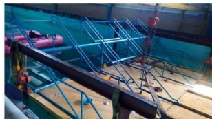
ج: رنگ‌آمیزی قاب‌های شابلونی بر روی زیرسازه
