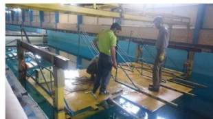
چ: نصب قاب‌های شابلونی بر روی زیرسازه
