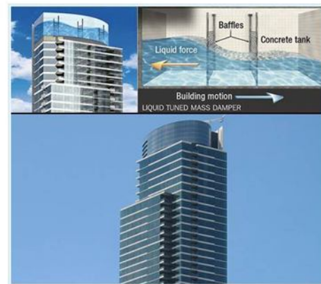
شکل ۲- برج مسکونی One Rincon Hill مجهز به سیستم TLD
