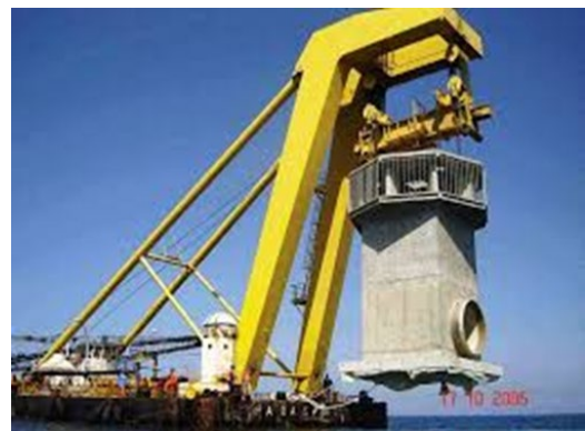
شکل ۱ - نصب کلاهک آبگیر برای آبیگری عمقی از دریا [۱]
