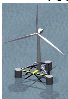
شکل ۱- ورق‌های هیو در پاشنه ستون‌های سکوی نیمه شناور یک توربین فراساحلی [۵]
