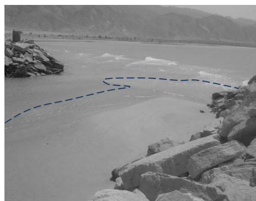
شکل ۴- وضعیت انباشت رسوب در دهانه بندر (۱۳۸۵)
