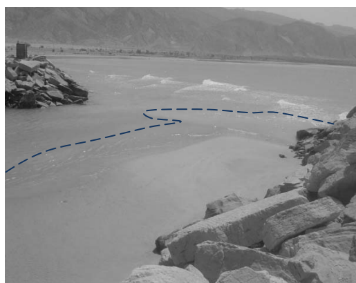
شکل ۴- وضعیت انباشت رسوب در دهانه بندر (۱۳۸۵)
