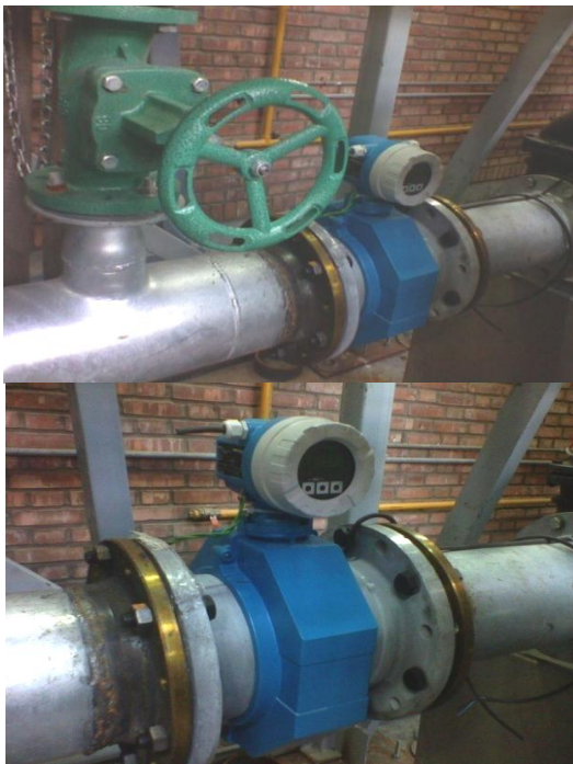
شکل ۱۰- دبی سنج مورد استفاده در تونل آب و شیر بای‌پس
