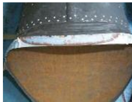
شکل ۳- ترک سطحی نیمه بیضوی پس از گسیختگی اتصال
